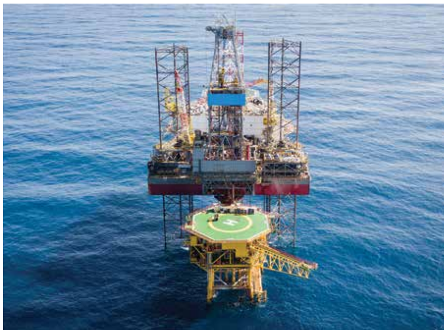
Giàn khoan tự nâng PV Drilling VI. Ảnh: PV Drilling
