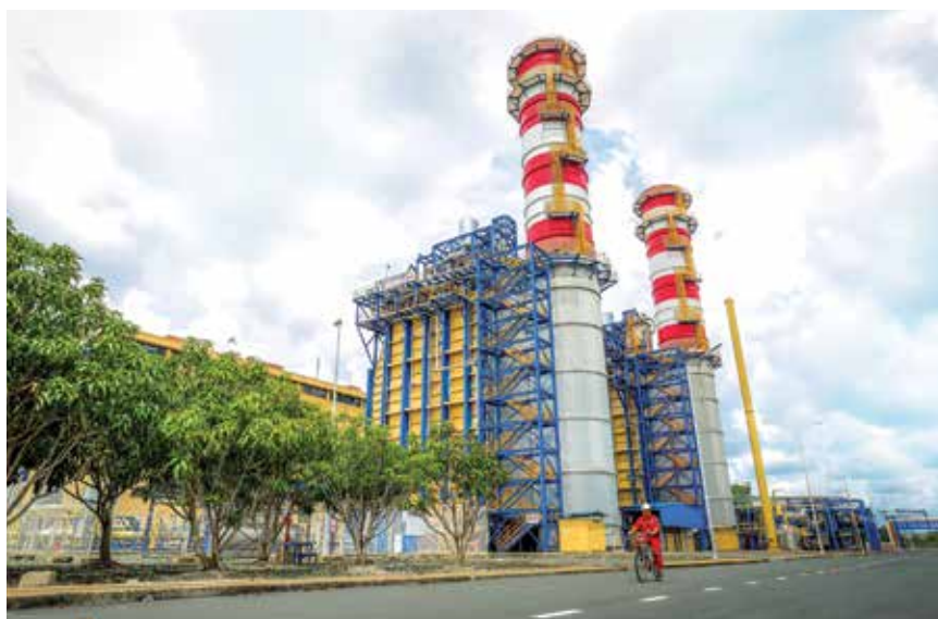
Nhà máy Điện Cà Mau 2. Ảnh: PV Power
